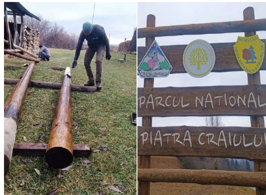
Recondiționare panou intrare parc dinspre Schitul Colții Chiliilor
