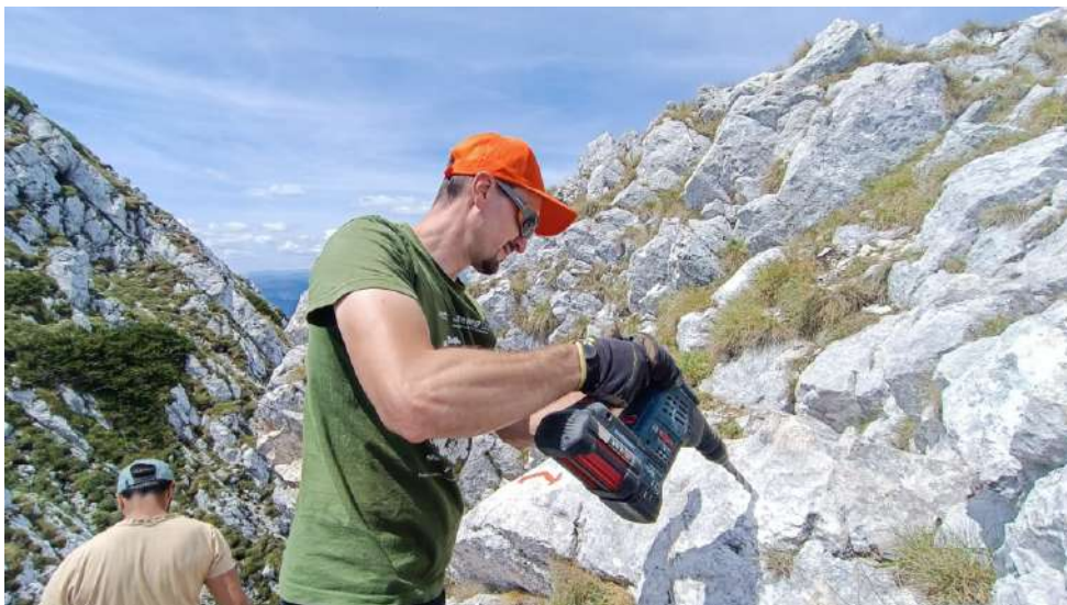
Reparare cablu și amplasare dispozitive de prindere ale acestuia pe traseul de creastă, secțiunea Vârful Ascuțit-Padina Popii
