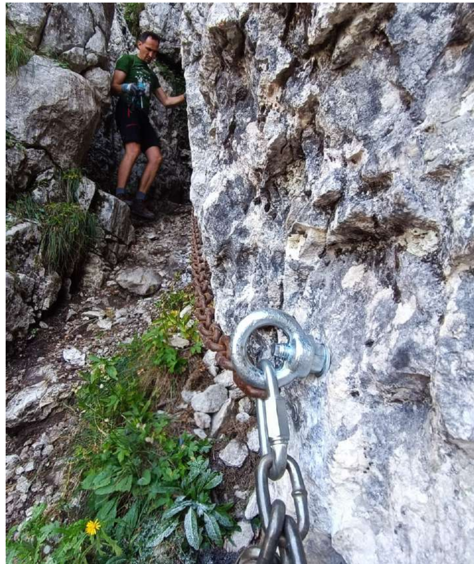
Înlocuire dispozitive fixare lanț de pe traseul Podul Călinețului-Brâul Ciorânga Mare-Vârful Ascuțit
