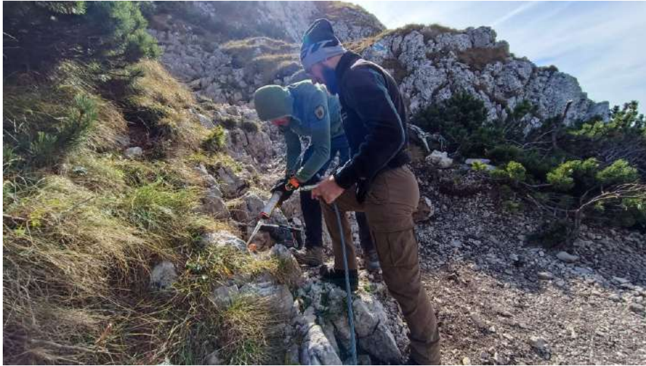
Înlocuirea și prelungirea primului cablu de la urcarea pe Vârful Piatra Mică
